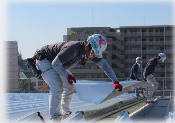
▲長尺屋根の折板現場成型
